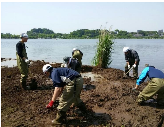
ビオトープ植栽前の湿地基盤づくり
