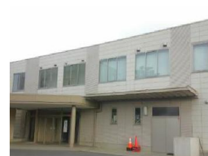
窓ガラスの遮熱塗装
