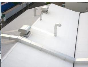
屋根の遮熱施工
